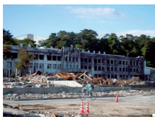
▲津波被害を受けた小学校
