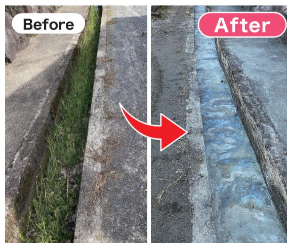
コンクリートが剥がれ、タニシが湧き泥の汚臭が漂っていた問題をコンクリート化で解消
