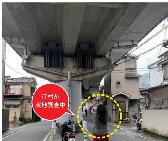
道路橋に住み着いた鳩の防害対策のため、柵の設置および忌避剤の対策強化。
