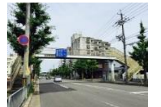
右京区・新宮歩道橋
